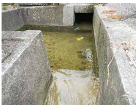
側溝の沈砂池
