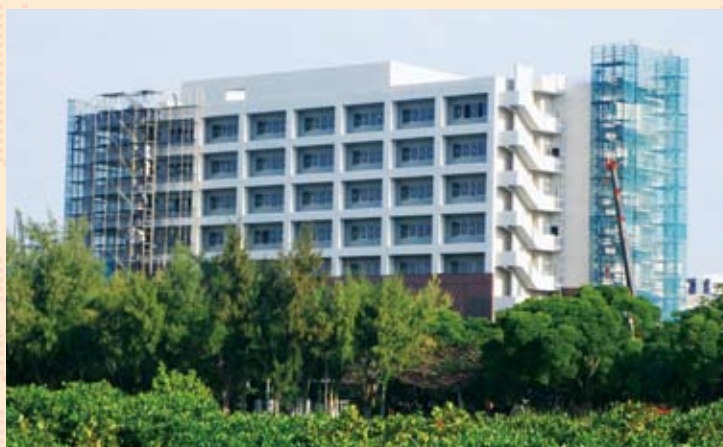
漫湖公園側から見た新病院
